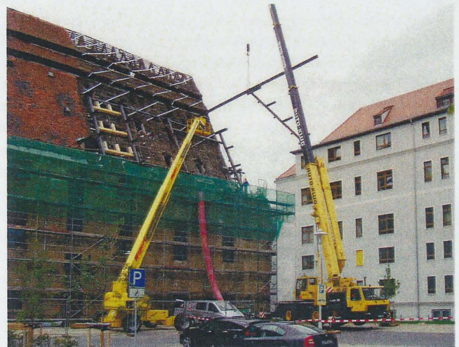
6 Kornhaus: Einbau der Hilfskonstruktion im Ostteil, Südseite (September 2009).
