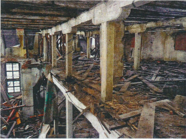
11 Kornhaus: Entkernung des einsturzgefährdeten hölzernen Tragsystems im Ostteil (August 2010).
