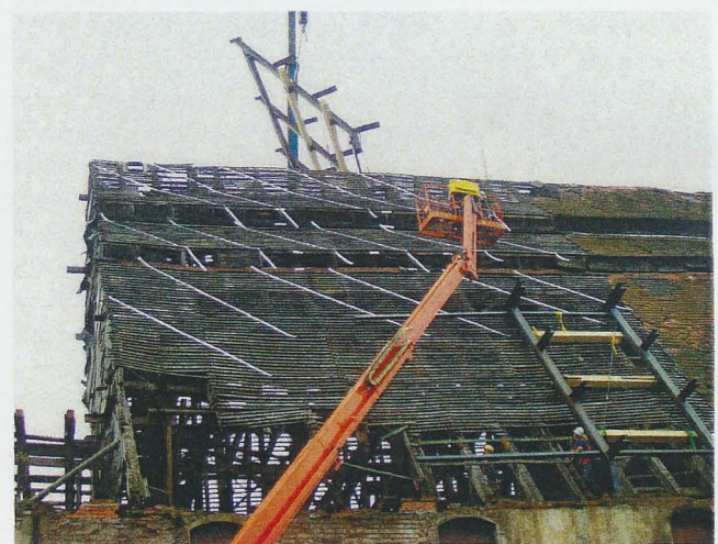
7 Kornhaus: Einbau der Hilfskonstruktion im Ostteil, Nordseite (September 2009).
