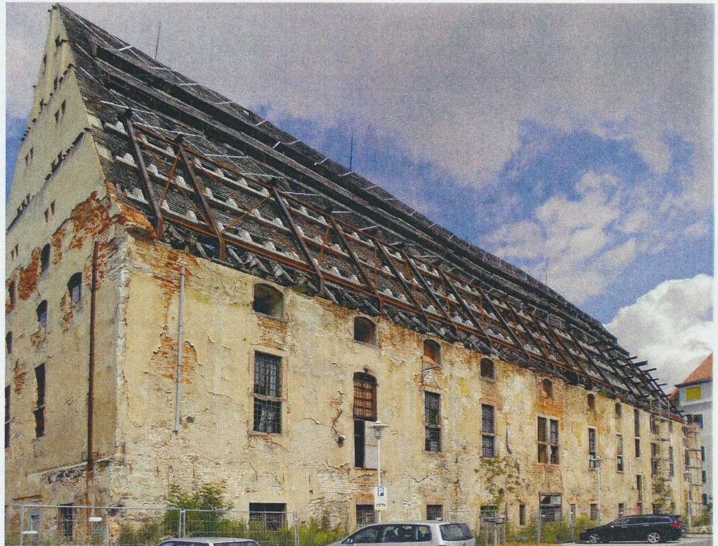
10 Kornhaus, Zustand mit eingebauter Stahlhilfskonstruktion im spätgotischen Dachwerk (Juli 2010).
