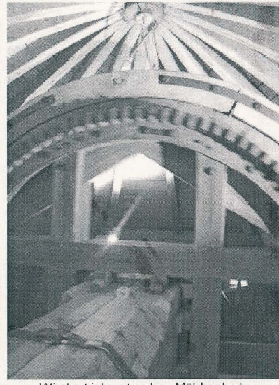
Windantrieb unter dem Mühlendach
